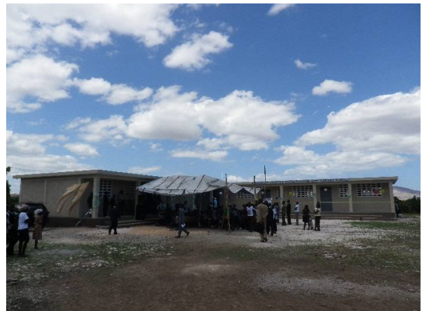
Le bâtiment construit
